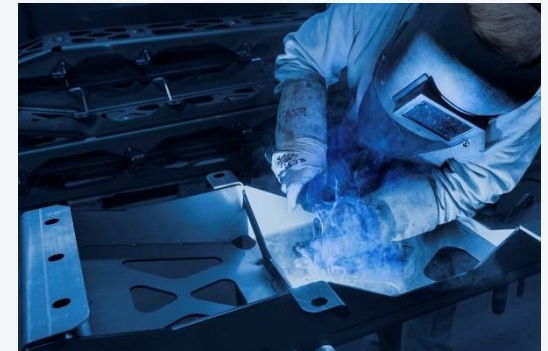
Zertifizierte Schweißtechnik: Automatisiert und manuell
